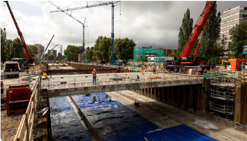
Verbouwing voor de nieuwe Amstelveenlijn bij de halte Kronenburg
